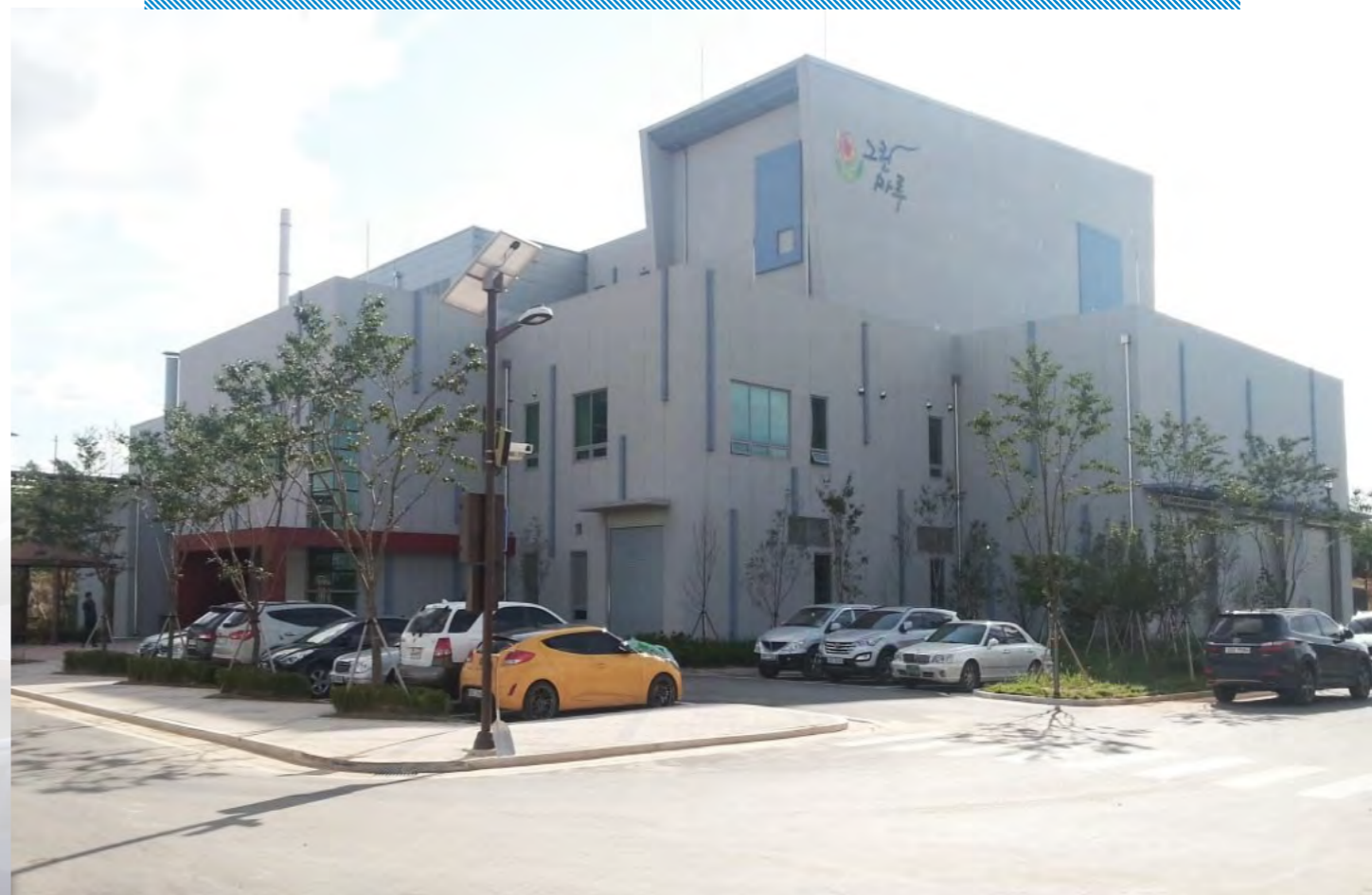
생활폐기물 전처리시설 전경 |
