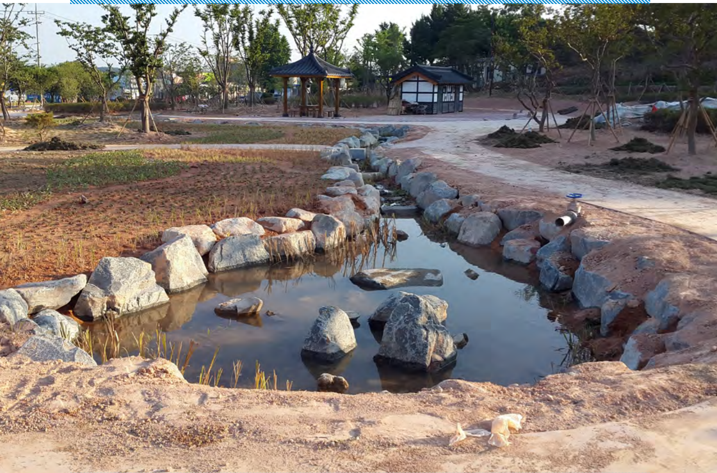
반남상로재 조성 현장 |
